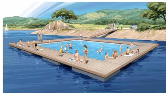
duradoura. Por outras palavras, para obter uma água simplesmente natural. O compartimento de banho está inserido numa estrutura pré-fabricada de aço e madeira. Os módulos são montados no local e ficam estabilizados na água por elementos flutuantes. A esta estrutura modular é acrescentada uma vasta esplanada com um acabamento final do tipo "marina". Trata-se da zona de estar e de lazer ao pé do compartimento de banho, e circundada pelas águas da barragem envolvente.
